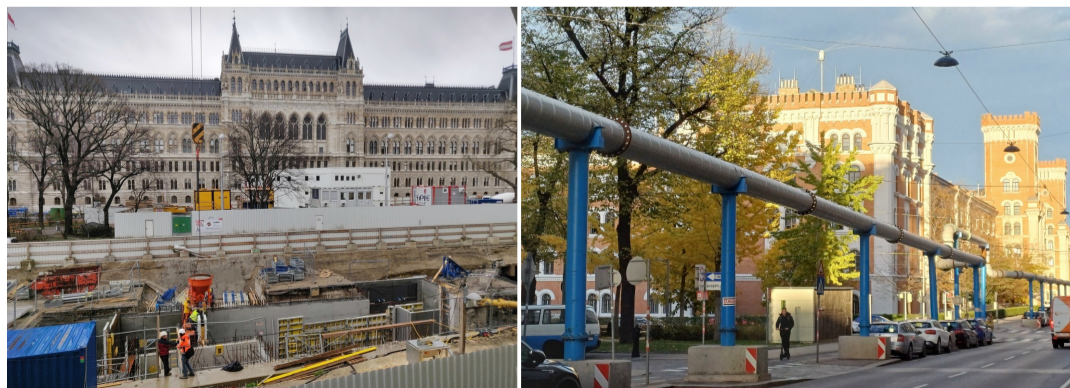
Links: Die Baustelle U-Bahn-Knoten U2xU5 Rathaus (Friedrich-Schmidt-Platz, 11.2.2022) zeichnet sich durch einen Grundwasserandrang und eine komplexe Wasserhaltung aus. Rechts: Das Wasser wird aus mehr als 100 Brunnen rund um die Baustelle abgepumpt und durch eine oberirdische Grundwasser-Sammelleitung auf Stelzen zum Donaukanal geführt.
