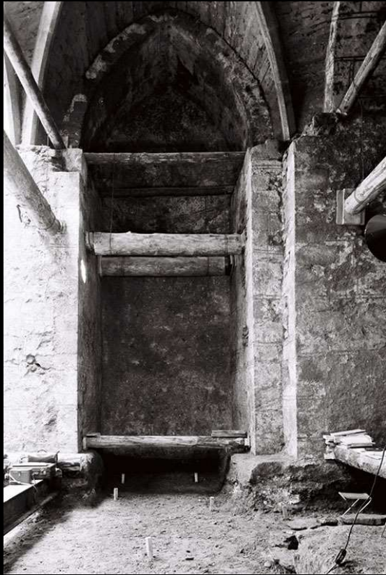
Nische 3 (NO) mit Pöhlung, Abgrabung unter Fundamentbereich für Betonierung.
