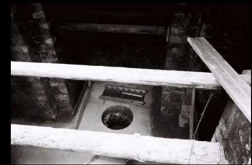
Nische 4 mit Brunnen nach Einbringen der Betonschicht.
