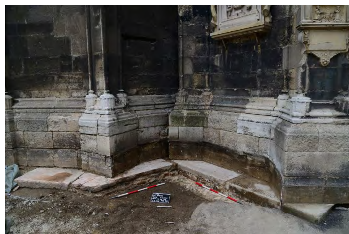
Abb. 7: Fundament Nordturm mit wiederverwendeten Grabplatten (Foto: Stadtarchäologie Wien, Ansicht nach Westen).
