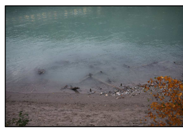
Reste einer Uferbefestigung am Inn. Foto: September 2019 A. Berthold
