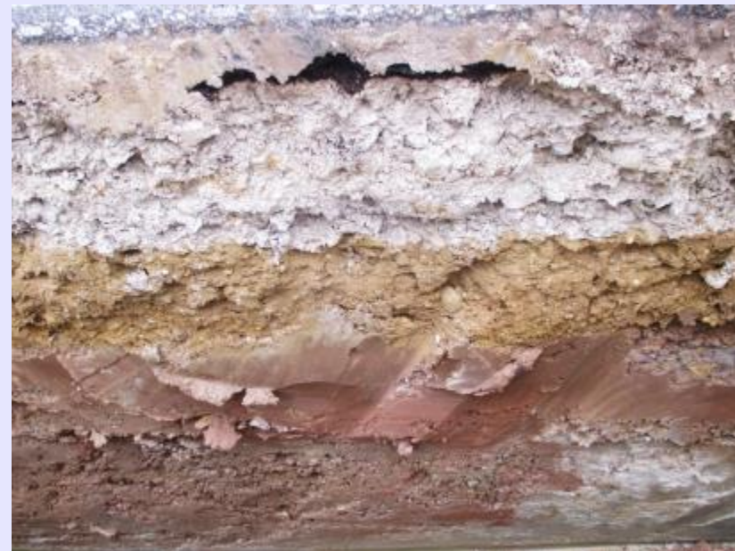
Künette Roterdstraße, 10/2016: Straßenbelag Grau: Anschüttung Gelb: Anschüttung Rot: Plastischer Schluff/Ton
