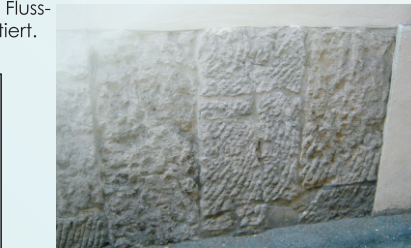
Römisch behauene Steine, eingebaut in einem neuzeitlichen Haus gegenüber Maria am Gestade.
